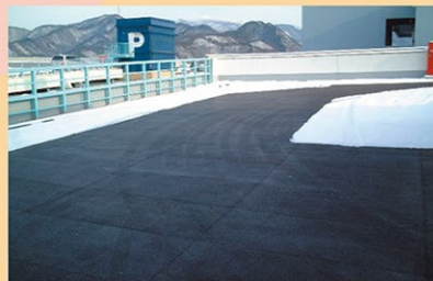
山形市屋上駐車場
