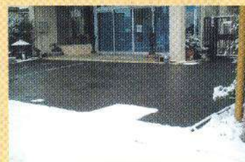
山形市商店駐車場
