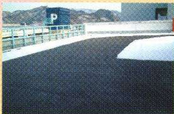
山形市屋上駐車場
